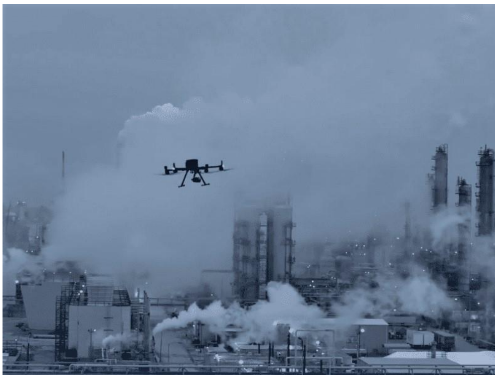
Рис. 1. Применение дрона для инспектирования трубопровода с высоты.
